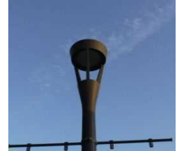
景観連続照明灯
