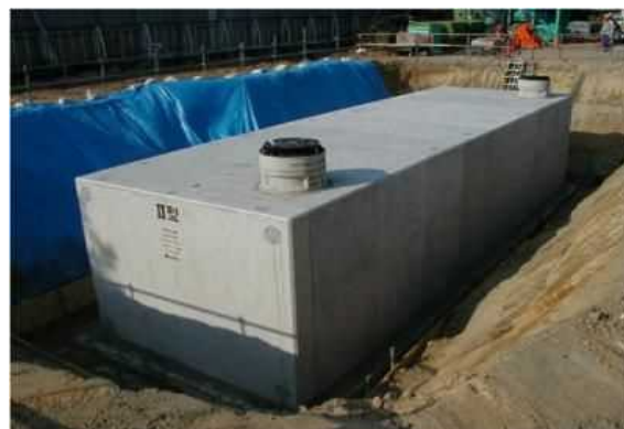
耐震性貯水槽施工イメージ写真
