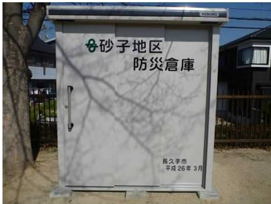
【地域防災倉庫】
