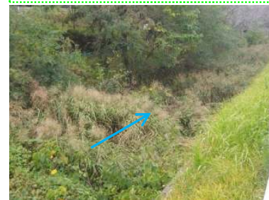
St-3一乃井橋下流
