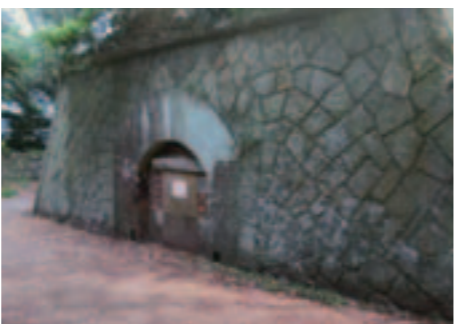
整備された弾薬庫
