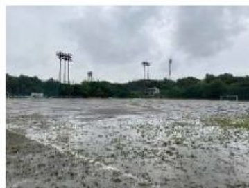
図 29 降雨時のスポーツの杜(多目的広場)
