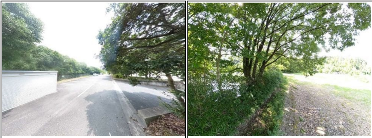
033 034 管理棟西駐車場 路面の損傷はほとんど見られない 北浦池東境界部 池からの吐き出し口は不明
