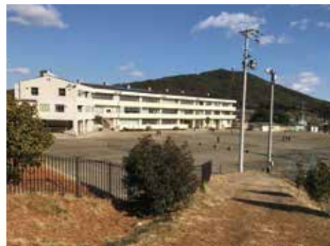
仮設住宅解体後(末崎中学校)
