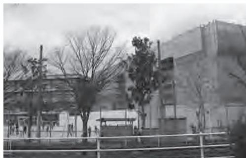
北小学校 校舎増築 工事
