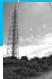
デジタルタワー
