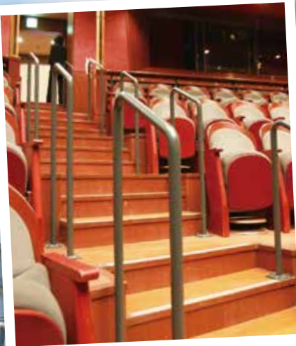
手すりの設置 (森のホール)
