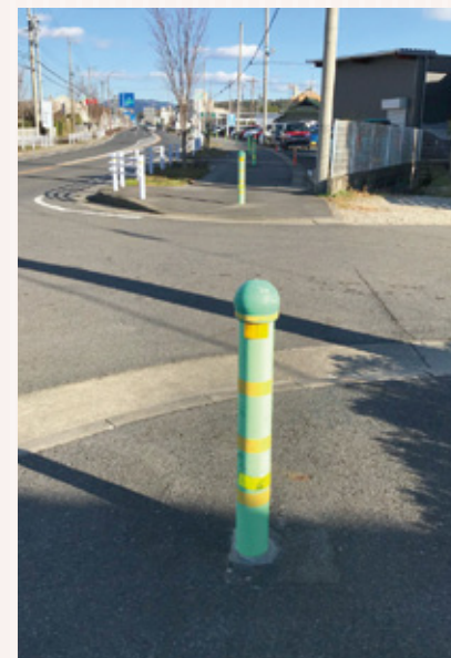
自転車や歩行者の通行の障害になっている車止めポール
