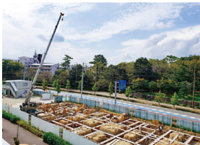
令和3年6月の供用開始に向け建設工事中的のリリモテラス公益施設
