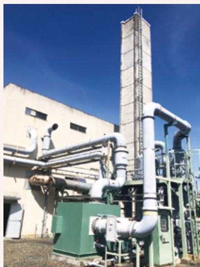
昭和50年に上川原に建設されたし尿処理施設香流苑
