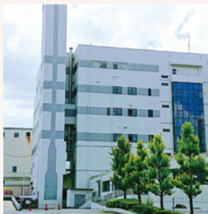
焼却炉の経年劣化が進んでいるごみ焼却場(晴丘センター)
