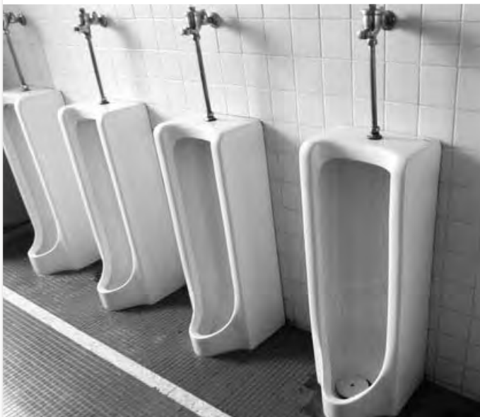
改修工事予定小学校のトイレ
