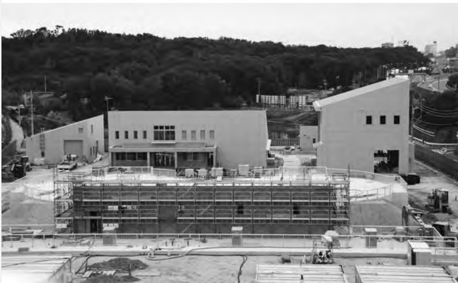
現在建設中の南部浄化センター
