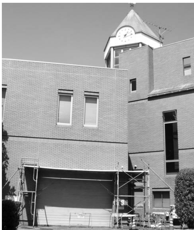
外壁の修繕工事をする中央図書館
