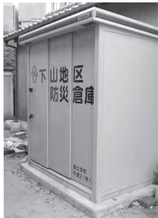
設置された防災倉庫
