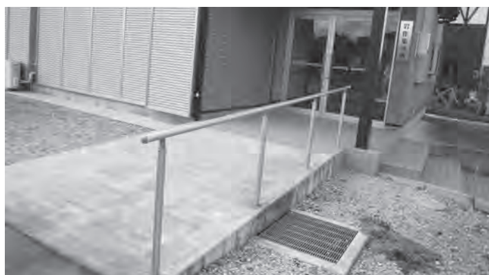
バリアフリー化された新設の集会所
