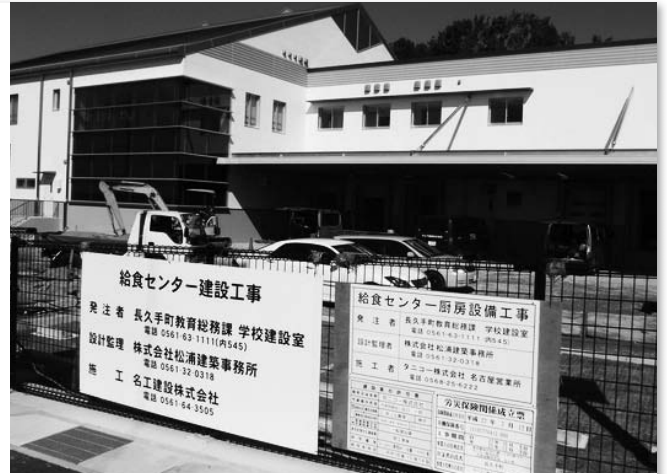
給食センターは12月初旬に完成予定、3学期始めの供用開始にむけて訓練が始まる。
