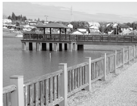
耐震診断済みの立石池
