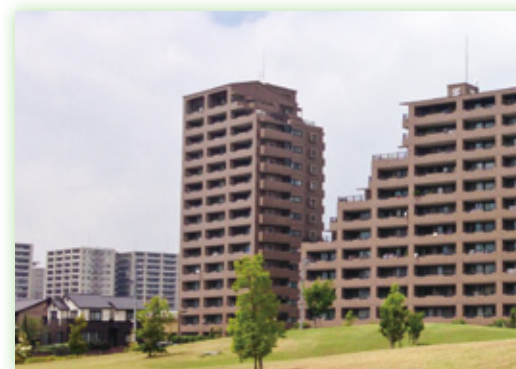
長湫北保育園移転新築予定地(鴨田地区)
