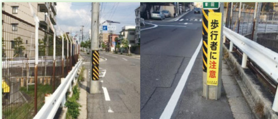
名古屋市名東区と長久手市の境界にある電柱を避けながらの通行が危険な状態であるという声は以前から寄せられていた。
