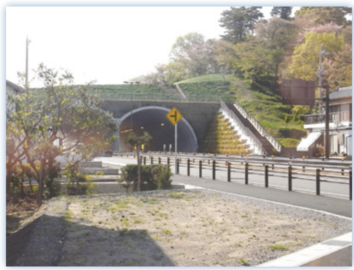
蒲郡荒子トンネル、古墳を移築、開削トンネルの上には散策路を整備
