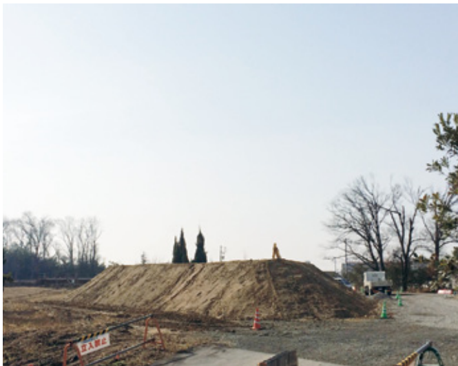
整備工事中の卯塚墓園
