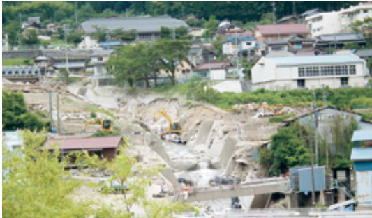
災害現場(7月24日撮影)
