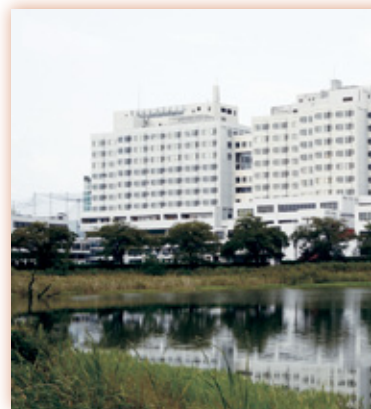
解体される愛知医大のA・B病棟（写
