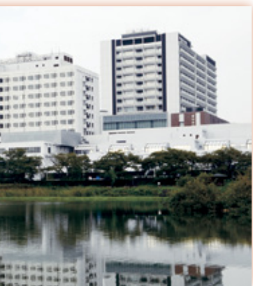
真手前)。アスベスト（石綿）が心配
