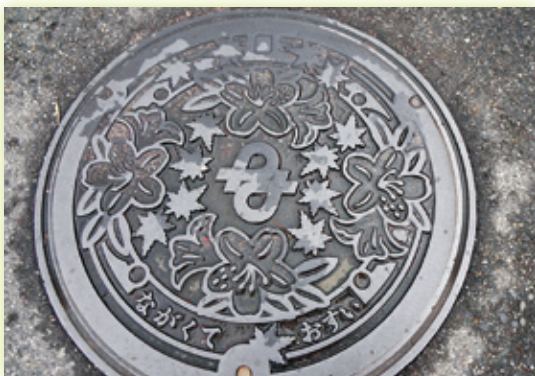
市の花サツキをデザインしたマンホールの蓋
