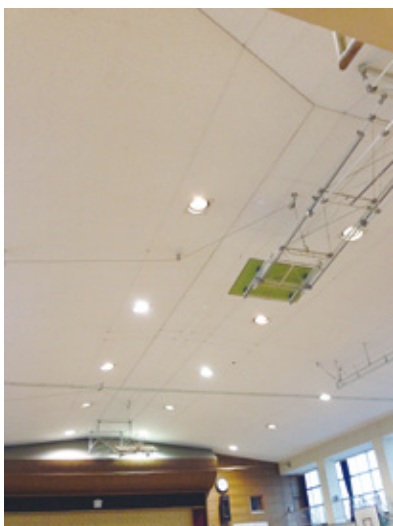
屋内運動場の天井
