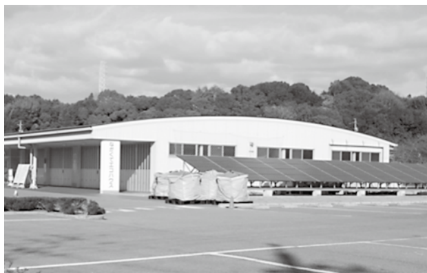
エコハウスの太陽光パネル
