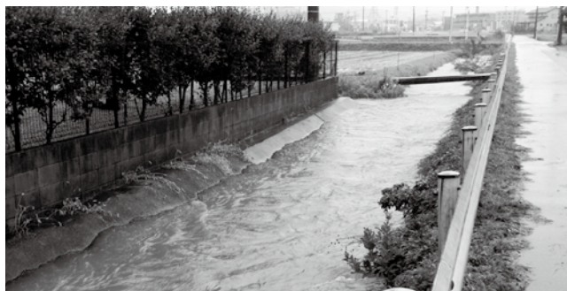
平成23年台風15号で冠水した藪田地区排水路
