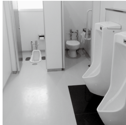
改修されきれいになった長久手小学校のトイレ
