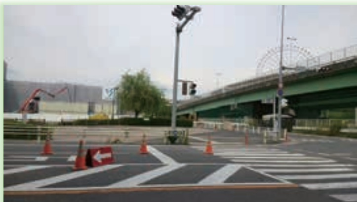
急ピッチで建設が進むイケア周辺
