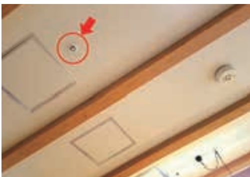
宿泊機能を備えた介護施設を対象に国の補助で設置されたスプリンクラー
