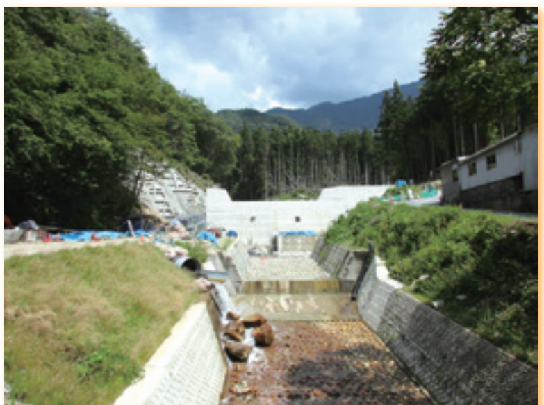
河川などの復旧工事が順調に進んでいる
