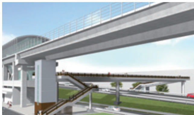
横断歩道橋工事は5億5,000万円の予算が計上された
