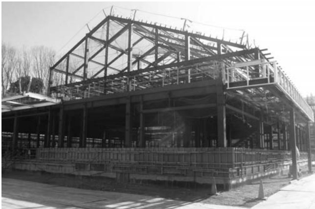
建設中の新給食センター工事
