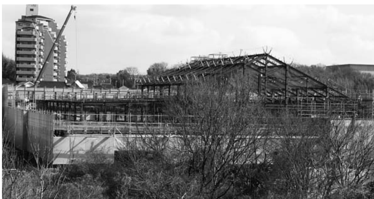
建設中の新給食センター 9月稼働の予定
