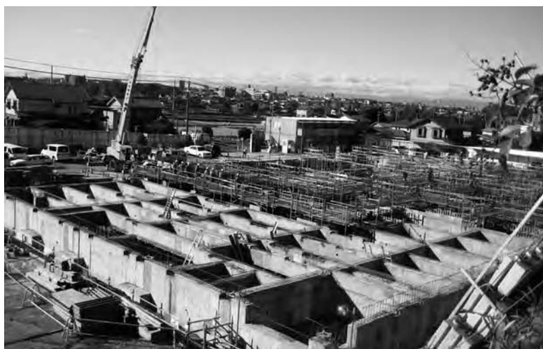
長久手中学校の東方に建設中の新給食センター
