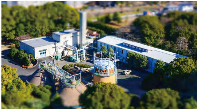
解体工事が進められる香流苑
