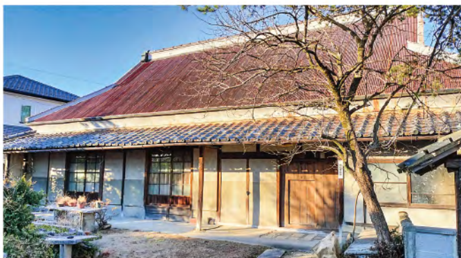
移設する古民家
