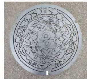
本市のマンホールふた
