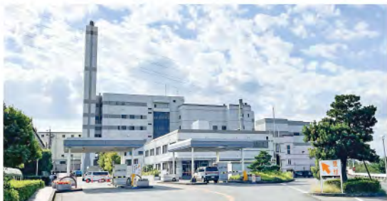
延命化工事が行われる晴丘センター
