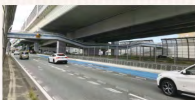
名二環高架下に設置された歩道橋
