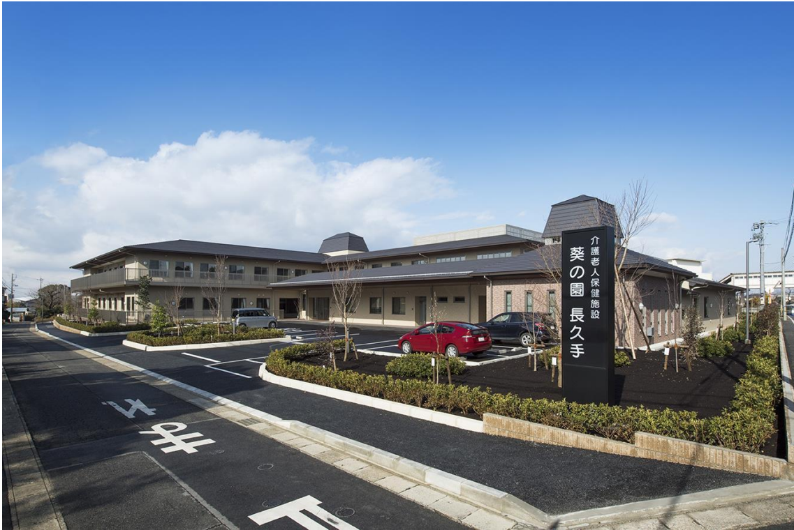
介護老人保健施設 葵の園・長久手 外観写真
