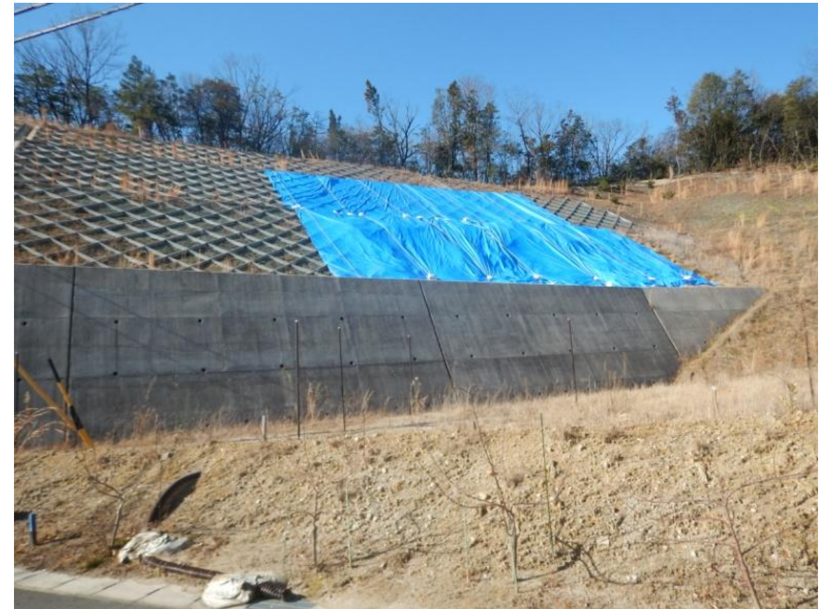
(2) 平成 29 年工事中
