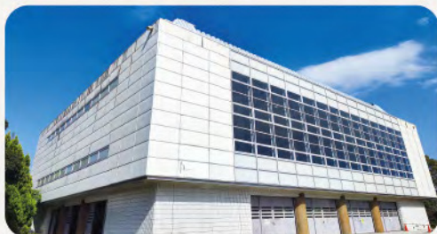
◀防災上有効な発電機は1施設のみ
