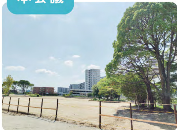
▲既に工事は99%完了「香流苑跡地」
