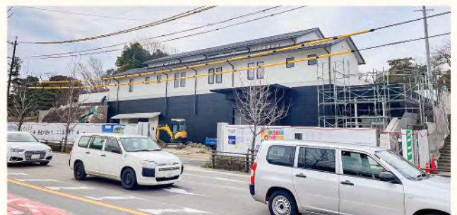
▲建設中の古戦場ガイダンス施設
