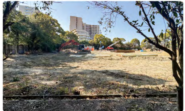
解体中の旧香流苑
