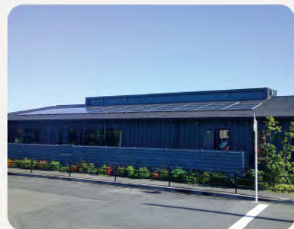
▲北ステに設置された太陽光パネル
