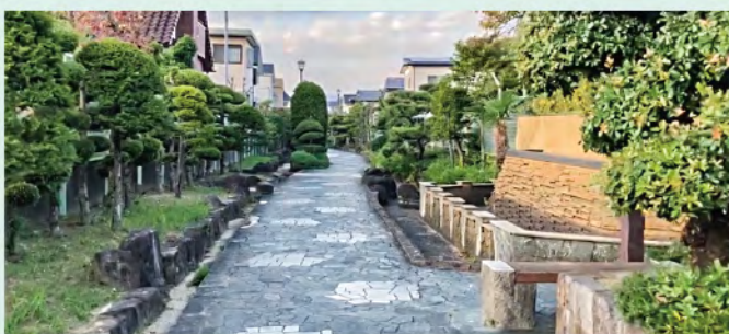
令和7年度に修繕工事を実施予定のせせらぎの径
