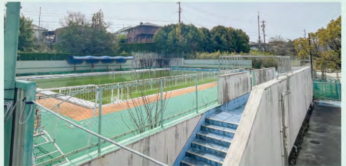
使用されていない西小学校のプール
