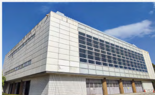
空調設備の可能性を探る杣ヶ池体育館アリーナ
