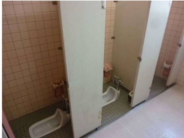
女子大便器(改修前)
