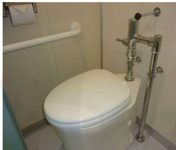
長久手小学校(改修後)
