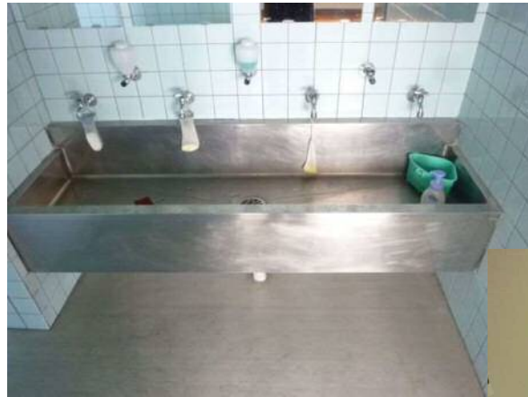
男子洗面台(改修前)
