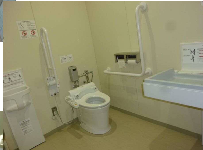
多目的トイレ(新設)
