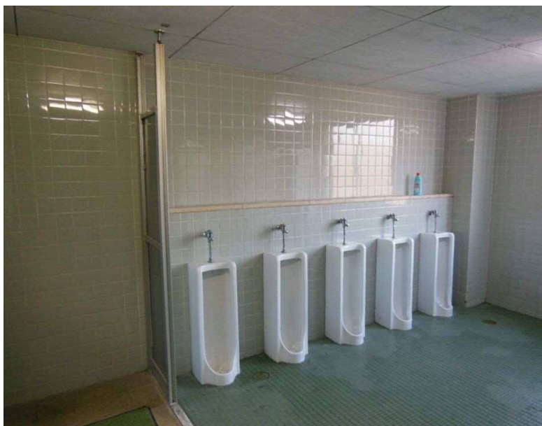
長久手中学校(改修前)
