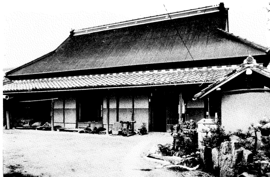
所在：愛知郡長久手町岩作字石田4番地 形式：入母屋平入、茅葺鉄板葺、鳥居建、農家 規模：桁行8間・梁間4間半 年代：当初18世紀中期、明治24年瀬戸市品野から移築
