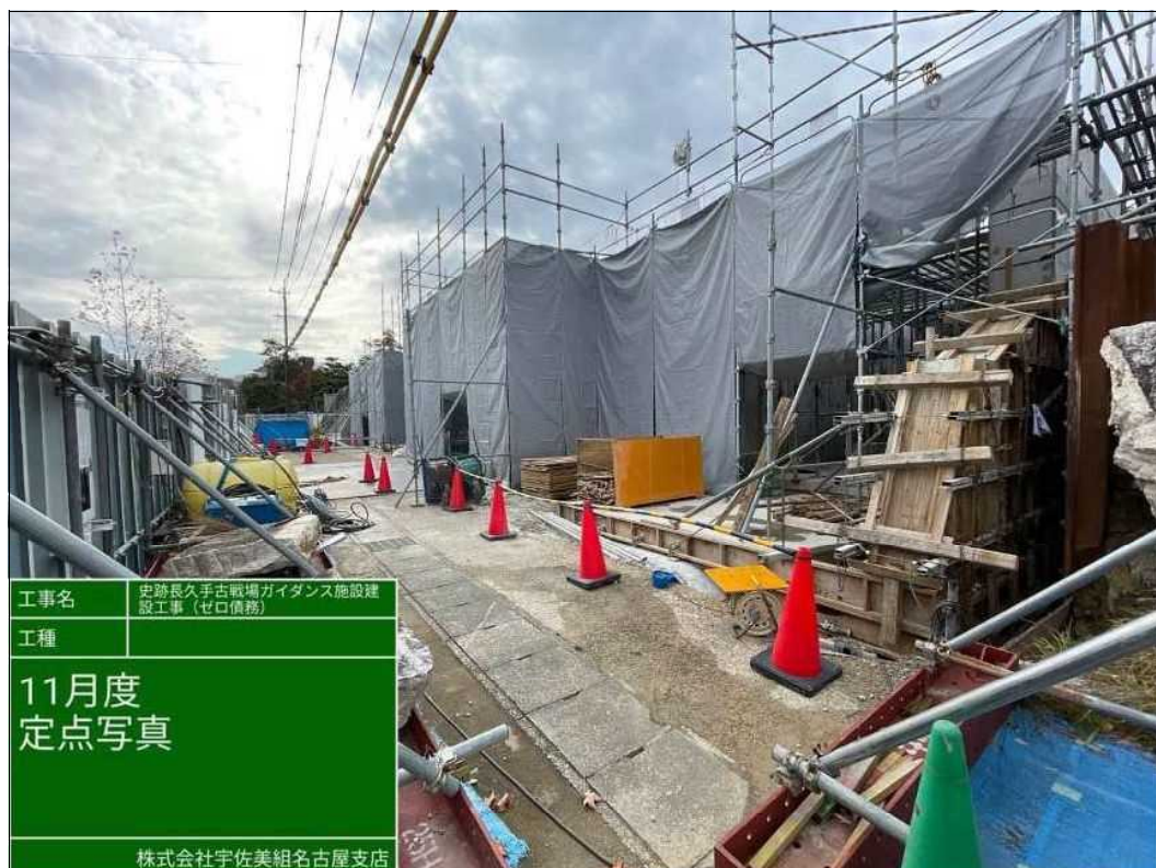
【11月】 地下1階躯体 コンクリート工事
