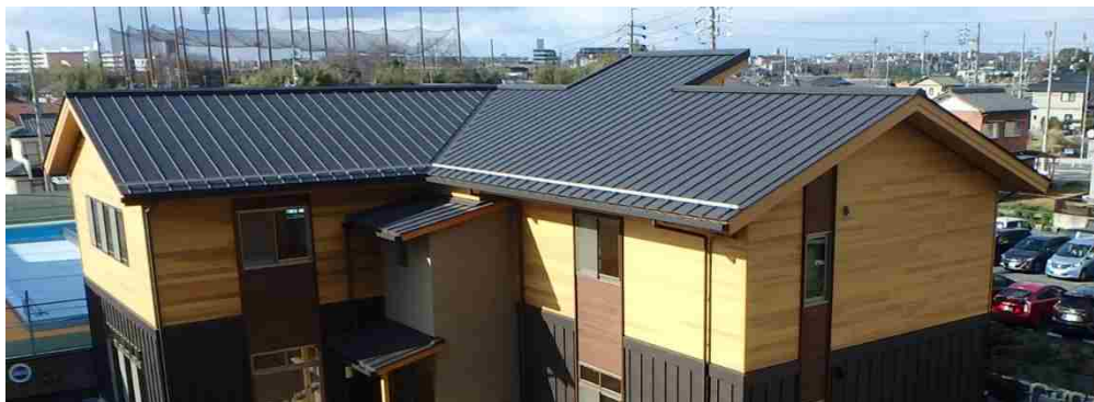
【写真 耐用年数の長い金属屋根の例（ガルバリウム鋼板）（北小学校多目的棟）】
