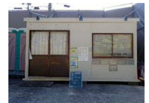
現場事務所・休憩場
