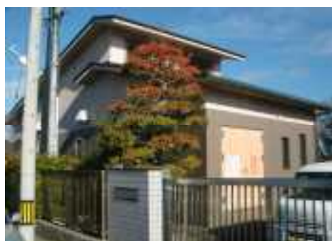
長久手中継ポンプ場
