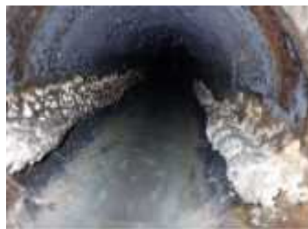
マンホール内目視調査
