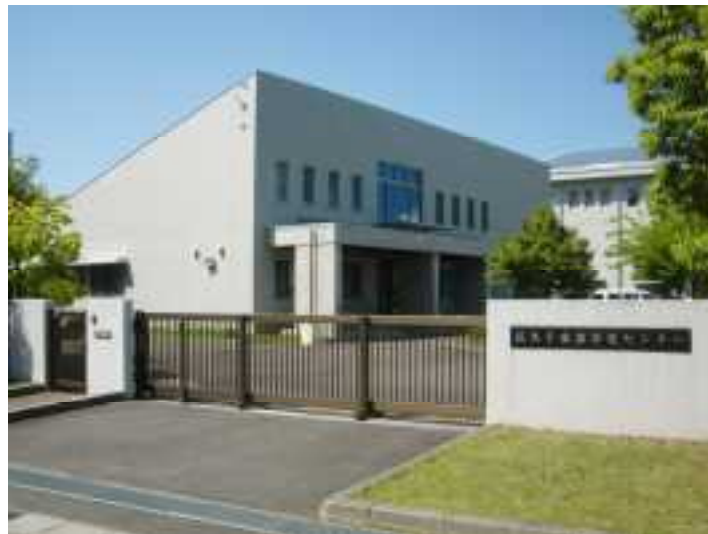
長久手南部浄化センター
