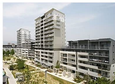
▲壁面を分節化した事例(他市)
