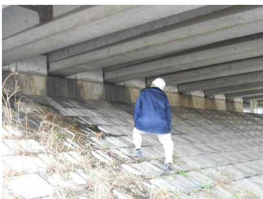
写真-3.3 職員による点検状況①
