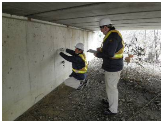
写真-3.1 専門業者による点検状況①
