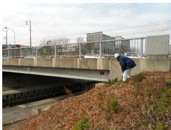
写真-3.4 職員による点検状況②
