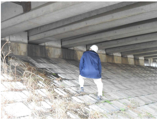
職員による点検状況①
