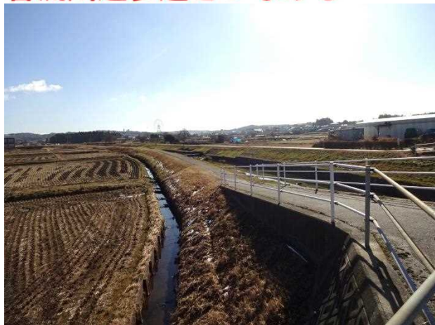
溝下橋上流右岸
